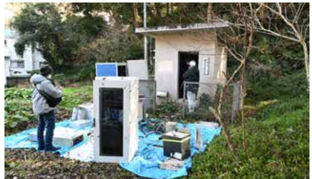
ひずみ観測施設の撤去工事（2023 年 1 月 24 日）
