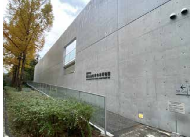
写真 8. 越知町立横倉山自然の森博物館（建物外観）
