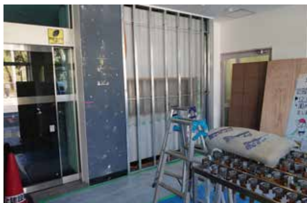
玄関ホールの壁面補強工事
