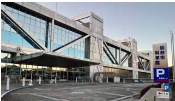
スリーエム仙台市科学館
