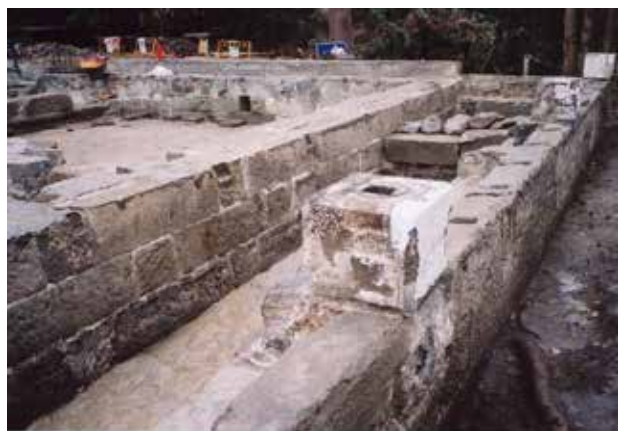
石積みの布基礎 (2003年12月5日撮影) 横須賀製鉄所副首長ティボディエ官舎
