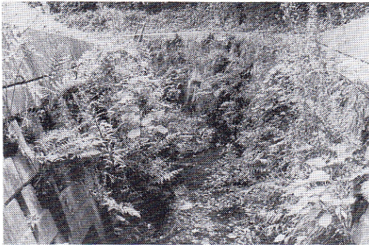
第19図 1989年の岩戸川B区(改修6年後)。St. 11付近の河川状況。中洲や護岸壁にはシダ類をはじめとし、多くの植物が繁茂している。ゲンジボタルが発生した流域である。
