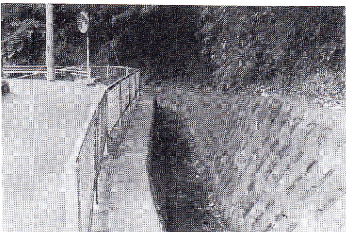
第8図 1989年の岩戸川E区周辺。川幅約1mで二面コンクリート護岸が施されているが一部は三面護岸となっている。
