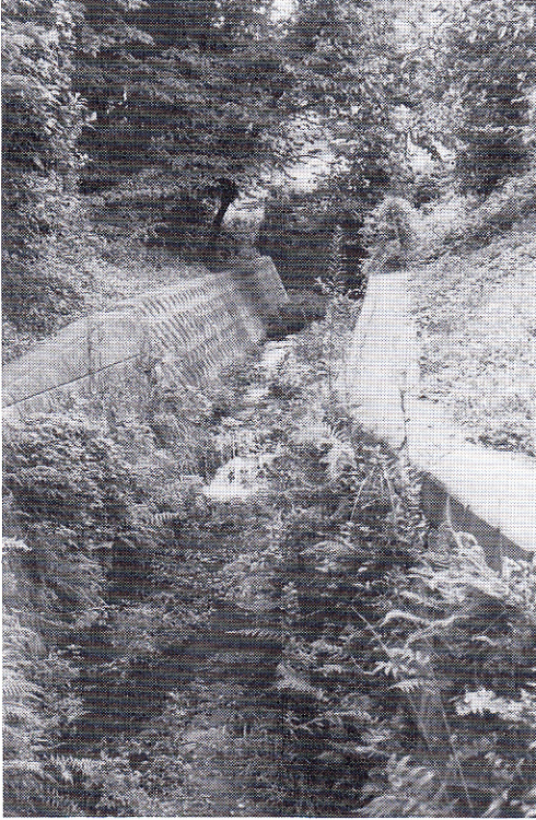
第17図 1989年の岩戸川B区のSt. 11からC区を望む(改修6年後)。特殊ブロックからシダ類が繁茂し、寄洲にはミゾソバ、セリなどが繁茂している。
