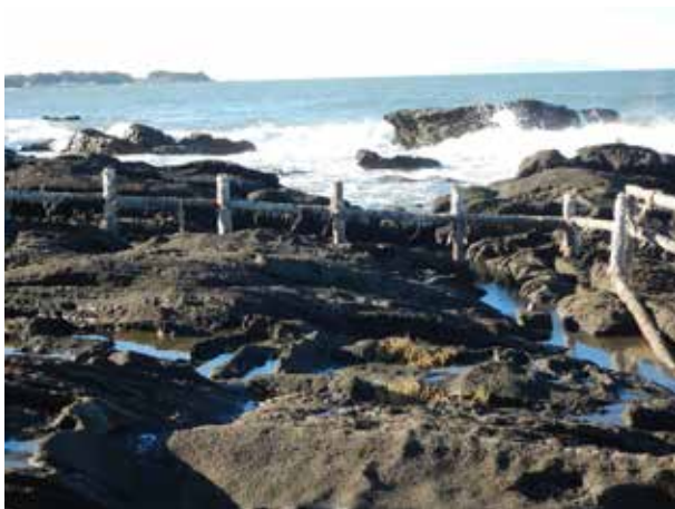
4-(1) 擬木柵の破損 (2019年10月13日)
