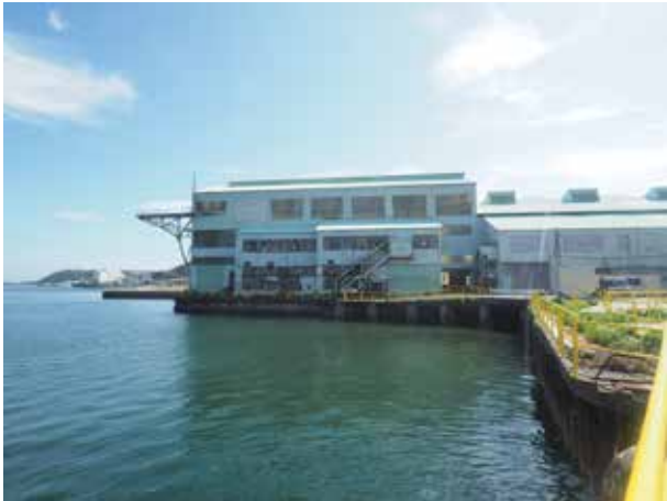
5-(2)-イ-(イ) 近代化遺産ツアー 1 (浦賀ドック機関工場遠景)
