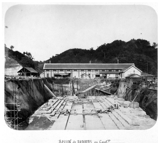
第3図 ドライドック1号建設中の写真。ドックは、地層(逗子層)の走向に直交する方向に掘削されていることがわかる。提供:「ファイル エミール モンゴルフィエ家, (Archives from Emilie de Mongolfier family)」。
