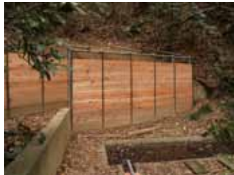
斜面崩落防止工事
