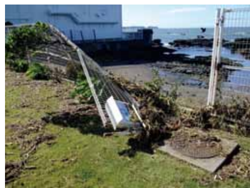
台風で倒れたフェンス (9/22)
