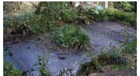
水抜きが終わり泥が現れた下の池 (1/27)
