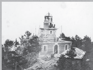
建設中の観音埼灯台（横須賀製鉄所が設計・施工）
