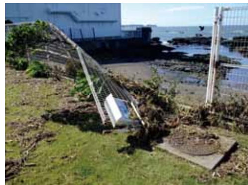
台風で倒れたフェンス (9/22)
